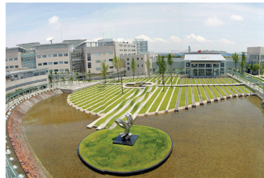
图一 数据中心外景
