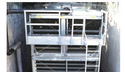
1500系列三面靠墙排布
